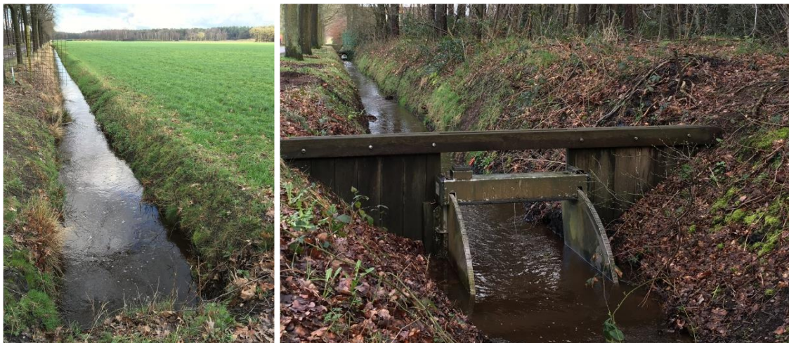
Diepe ontwatering van buitengebied bij Landgoed Putse Moer. Stroomafwaarts moet een recent geplaatste stuw neerslag langer vasthouden, maar die stuw stond en staat nog altijd wagenwijd open. Putte, 11 maart 2020.
